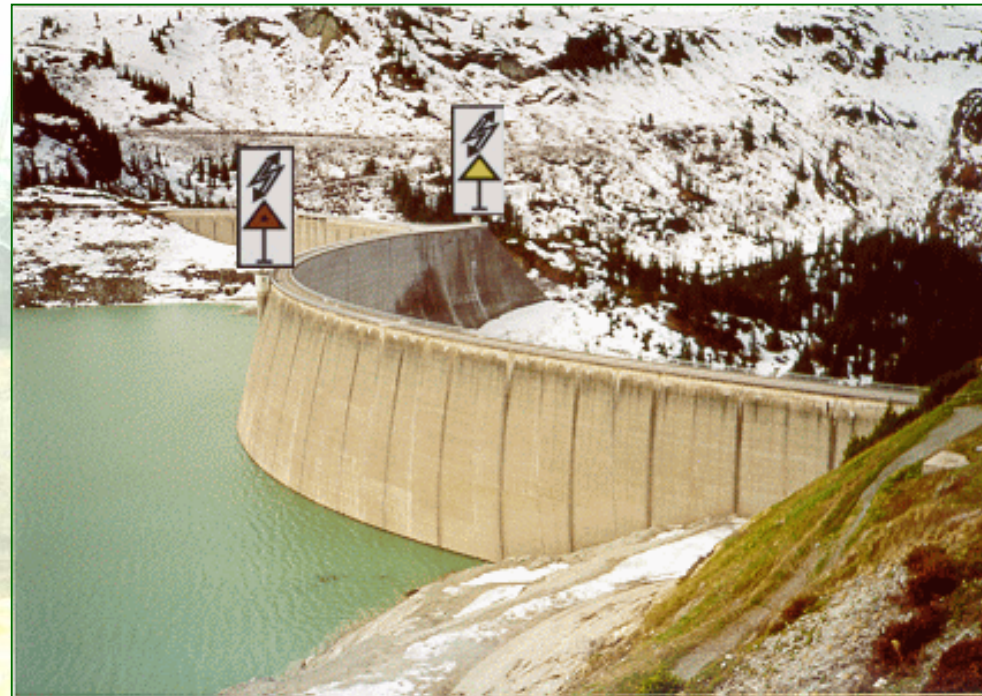
Rot: GPS-Rover als Objektpunkt-1 im Bereich der Mauermittle Gelb: GPS-Referenzstation als Objektpunkt-2 im künstlichen Widerlager
