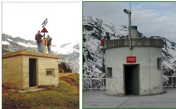
Рис. 9: Установка опорной точки X_R (слева) и точки объекта x_O(t) в месте соединения дамбы со скалой (справа)
