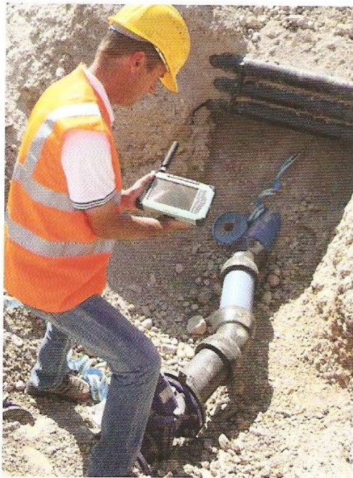
Leitungseinmessung mit dem Leica CS25 GNSS plus
